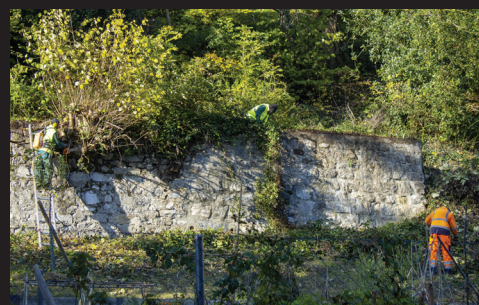
Travaux sur le mur de soutènement du plantage
