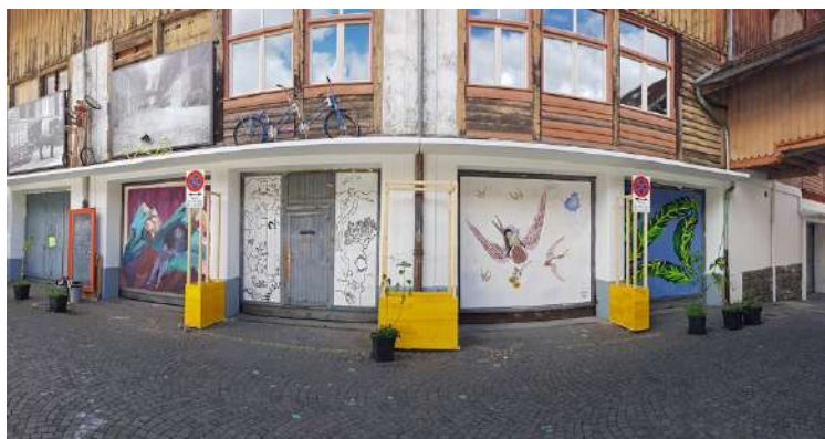
La Cour et les entrées des Garages, vue extérieure
