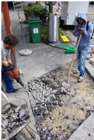
Démolition de l'asphalte
