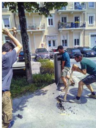
Arrachage de l'asphalte au pic
