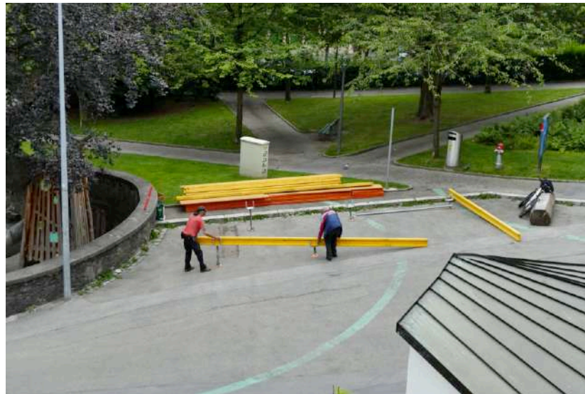
Re-construction du podium en juillet 2020
