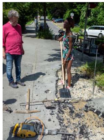
Dépose de l'asphalte
