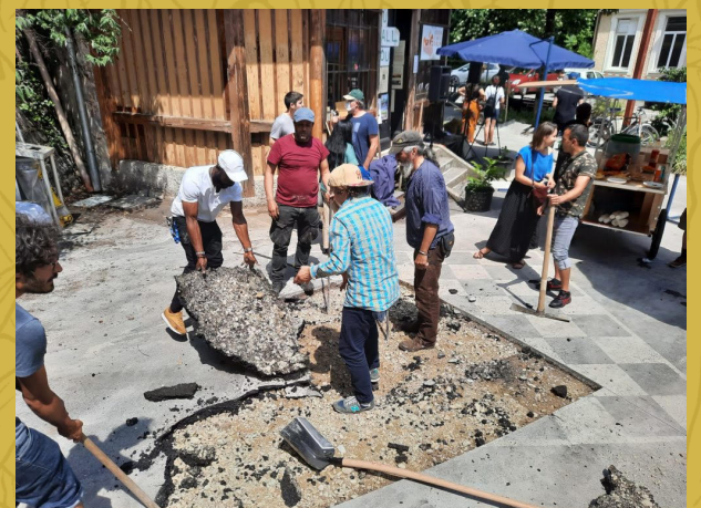
Les Mains dans la place, relance du chantier, 12 juin 2021
