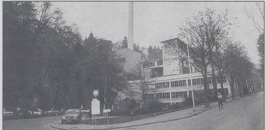
Pour 180 millions, l'usine d'incinération du Vallon, datant de 1958, devrait être remplacée d'ici à cinq ans.
